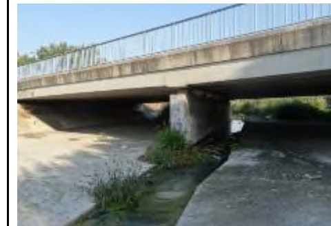
A gauche : passage existant au niveau du Cadereau d'Uzès, présentant une faible naturalité A droite : passage présentant une plus grande naturalité (berges enherbées, conservation du lit du cours d'eau) et donc une meilleure franchissabilité par la faune.
